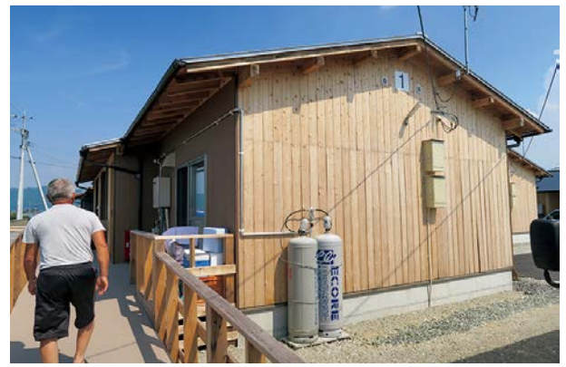
写真3 「木造」仮設住宅 (宇城市小川町)
