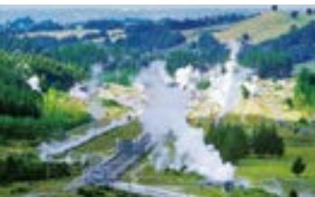
↑9 ワイラケイ地熱発電所(ニュージーランド) 火山の多いニュージーランドでは、地熱の利用が進められている。
