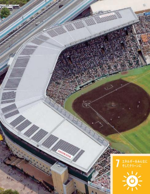
**↑1** 阪神甲子園球場の屋根に設置された太陽光パネル(兵庫県西宮市) この太陽光パネルが1年間で発電している電力量は、ここを本拠地とする球団Hが1年間にこの球場の夜間試合で使用する照明の電力量に相当します(→p.198)。
