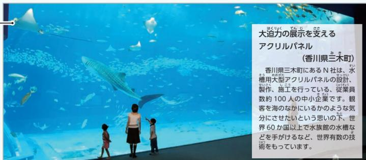
↑1 沖縄美ら海水族館に設置された幅22.5mのアクリルパネル(沖縄県本部町) この大型のアクリルパネルは、高い強度のアクリルを何層にも重ねることで、大きな水圧に耐えることができます。それにより、一本の柱も使わずに迫力ある展示が可能になっています。
