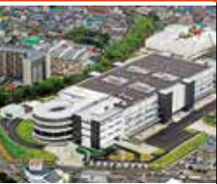
↑7 宅配便事業会社の総合物流施設(大阪府、茨木市、2017年) 名神高速道路の茨木インターチェンジの近くに立地しているため、関西国際空港や大阪国際空港、大阪港、神戸港への利便性が高い。
