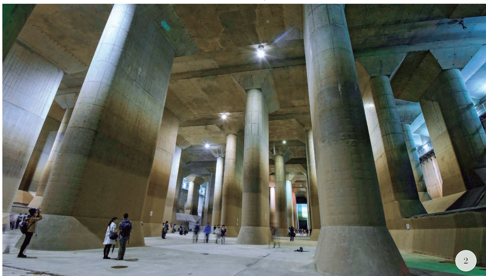
■p.239 首都圏外郭放水路（埼玉県，春日部市，2015年撮影）
