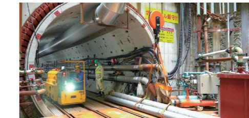
↑3 雨水をためて水害を防ぐ地下水路の建設(2020年)
