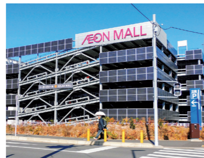
↑2 壁面に太陽光パネルが設置されたA社のショッピングセンターの立体駐車場(神奈川県産南市、2020年)
