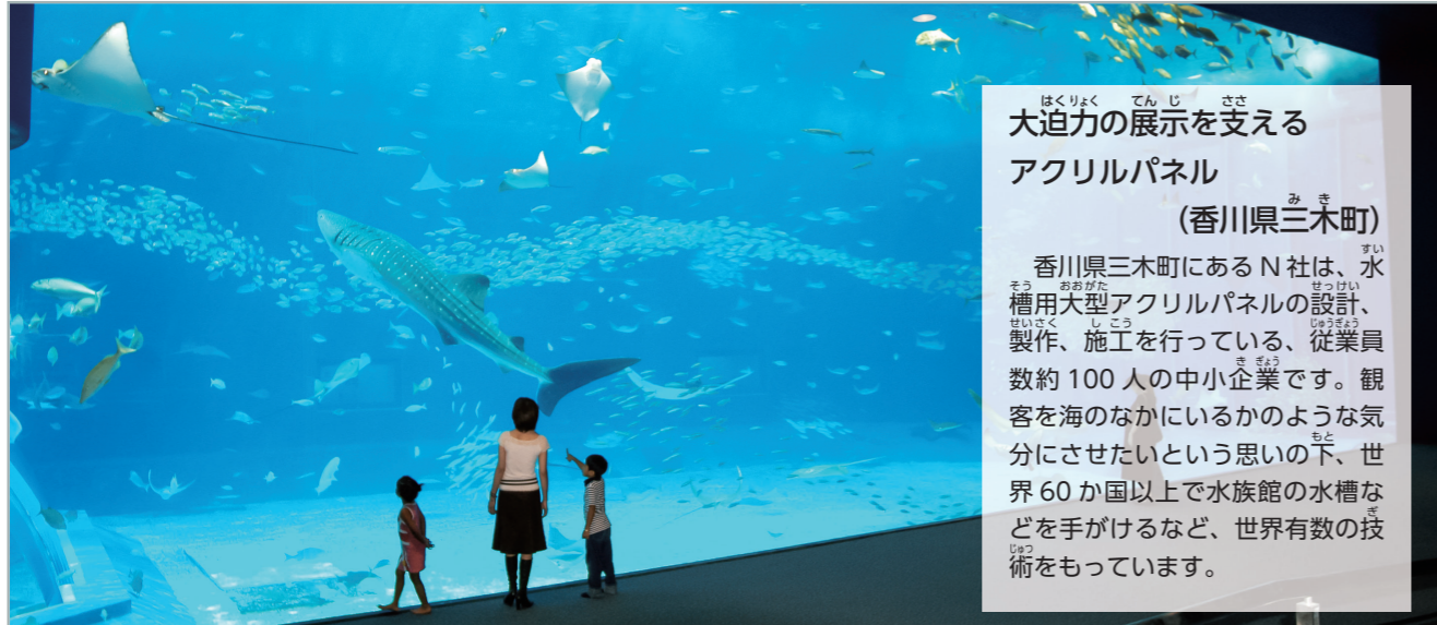
↑1 沖縄美ら海水族館に設置された幅22.5mのアクリルパネル(沖縄県本部町) この大型のアクリルパネルは、高い強度のアクリルを何層にも重ねることで、大きな水圧に耐えることができます。それにより、一本の柱も使わずに迫力ある展示が可能になっています。
