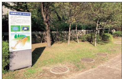
↑写真3 港区立芝公園内の災害用マンホールトイレ 災害時にトイレになるマンホールトイレなど災害に備えた施設が設置されている。
