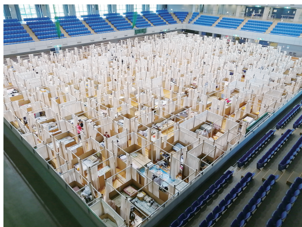
豪雨に見舞われ、「避難所用・紙の間仕切りシステム」が設置された熊本県人吉市（2020年）。紙管で柱と梁を組み立て、目隠し用の布（カーテンのように開閉可能）をかければ、体育館のような避難所でもプライバシーが確保できる。東日本大震災の被災地でも設置され、新潟県中越地震の間仕切りシステムから4バージョンめになる。2016年のイタリアの地震災害時には、海外で初めて設置された。 photo by Voluntary Architects' Network
